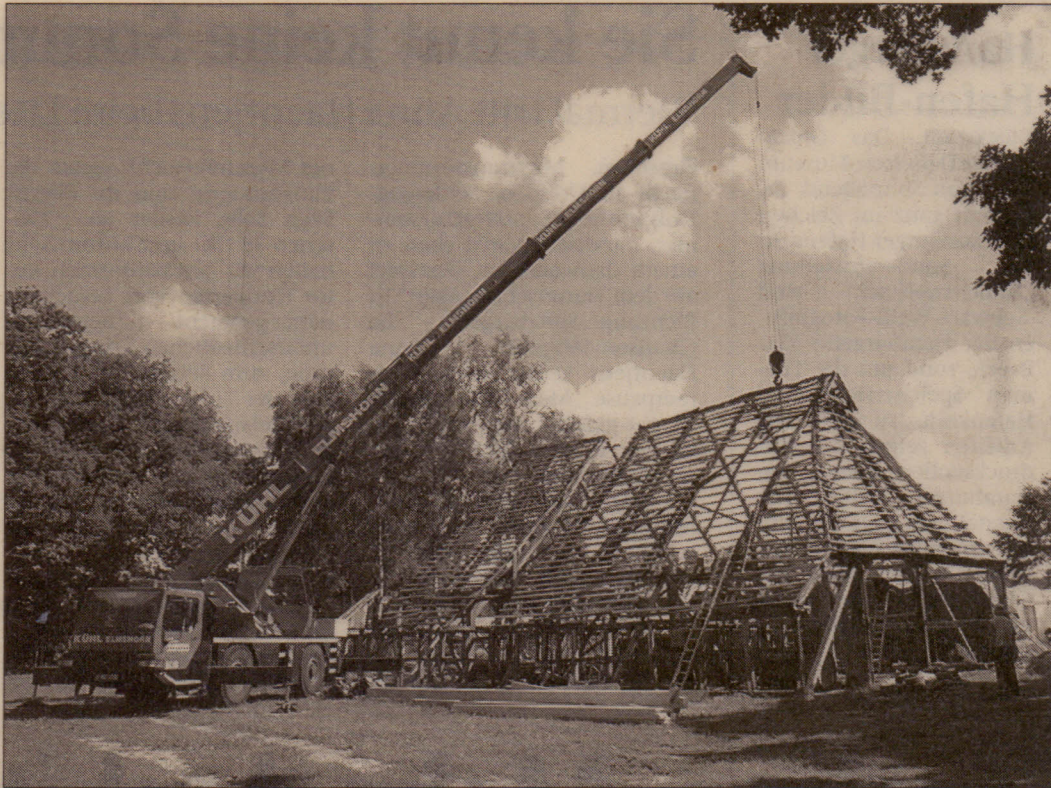
Ein Spezialkran hob diese Woche die tonnenschweren Eichenbalken auf die rund 300 Jahre alte Scheune von André Rostock in Kölln-Reisiek.
